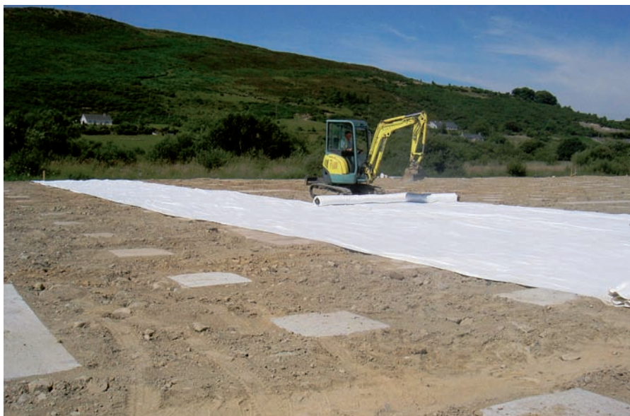
► Les géosynthétiques TenCate Geolon® PET proposent une solution à la fois économique et performante pour le renforcement des bases de remblais routiers.
