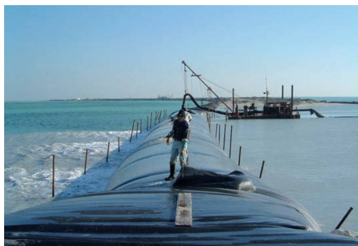
► Pour contrer efficacement l'érosion des côtes, l'installation de Géosystèmes TenCate Geotube® permet également d'utiliser des matériaux de construction pris sur site, contribuant à la réduction d'émissions de CO 2 .
